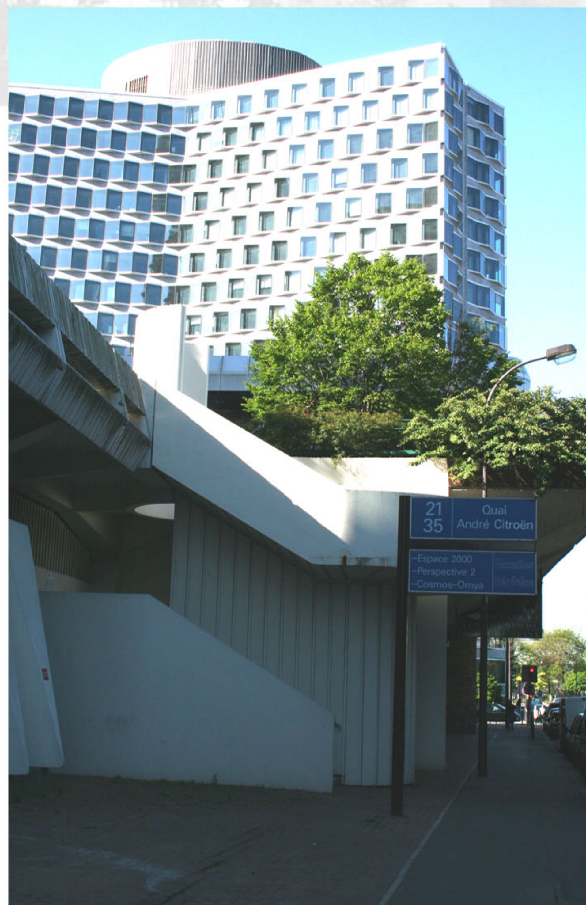
Escalier quai André Citroën
