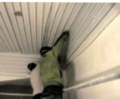
La méthodologie d'exécution prévoit tout d'abord la pose d'un maillage métallique : la fixation de ce treillis sur la structure portante, nécessaire pour assurer une bonne adhésion du flocage, risque de générer des nuisances sonores ponctuelles. La SemPariSeine, en coordination avec la maîtrise d'œuvre et
