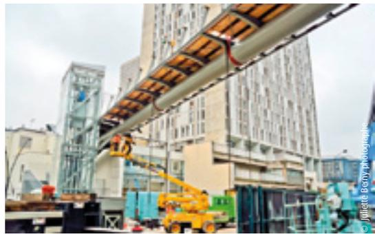
Arrivée par convoi exceptionnel, la passerelle Keller a nécessité l'utilisation d'une grue et de deux nacelles pour sa mise en place le 8 décembre dernier.
